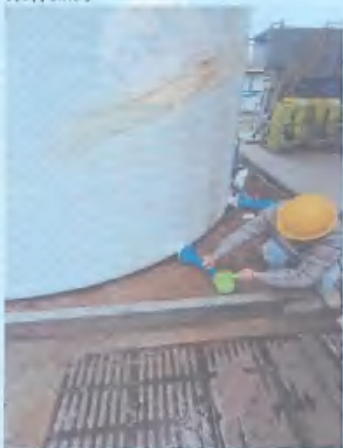
工业废水排放口
