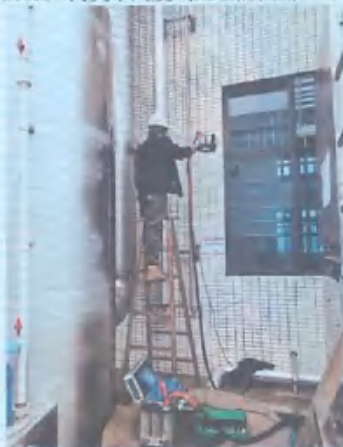
DA002 甲类 A 车间废气处理前检测口 G8
